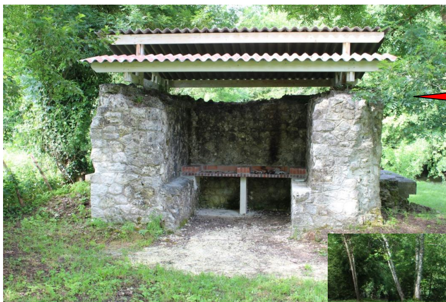
Le barbecue, dans la pile du pont de l'ancienne voie ferrée.
