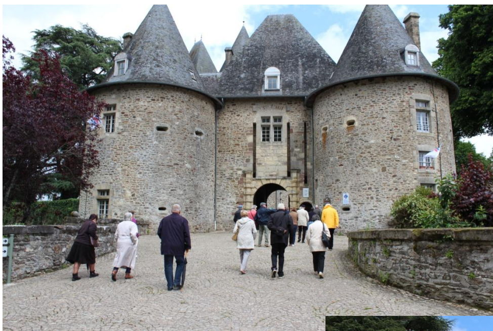
Le château de POMPADOUR.
